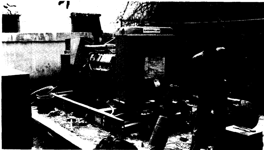
Juin-juillet 1982, dans le faubourg sud de la banlieue de Beyrouth : la station de pompage a été détruite par les bombardements aériens, les réservoirs sont vides. Ce groupe permettra de pomper sous la ville et de remplir des réservoirs mobiles ou placés sur les toits des immeubles.
